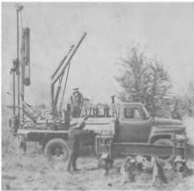
Рис. 103. Копер для забивки моделей свай
